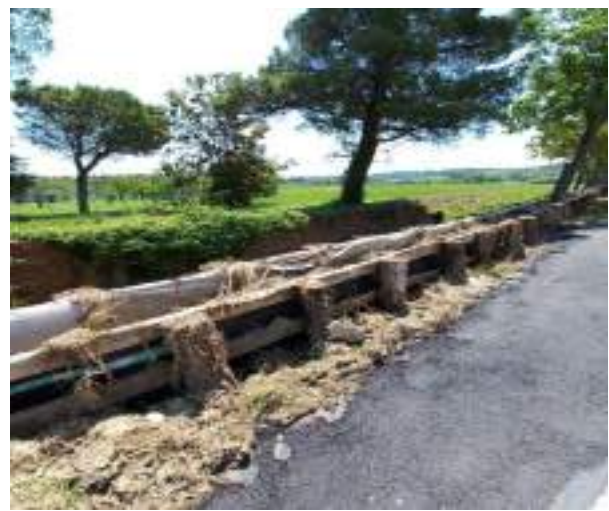
Idrovoro Rio Casale: allagamento dell'impianto e sormonto dell'arginatura naturalistica con asportazione del materiale di riempimento
