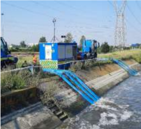
Pompaggio ausiliario idrovoro Canala – Team Slovacchia (800 l/s) e Team Francia (1000 l/s)
