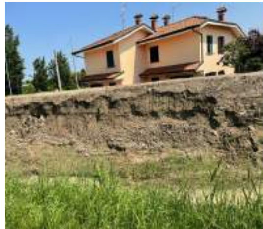
Torrente Rigossa: erosioni diffusa e rottura arginale in sponda destra conseguenti al transito dell'onda di piena
