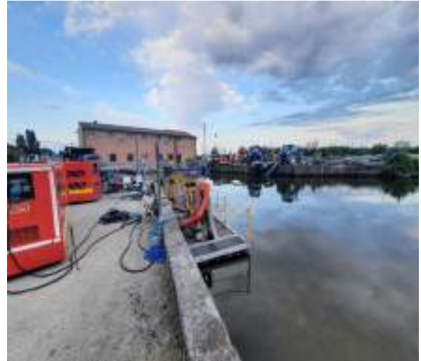
Pompaggio ausiliario idrovoro Canala – Team Slovacchia (800 l/s) e Team Francia (1000 l/s)
