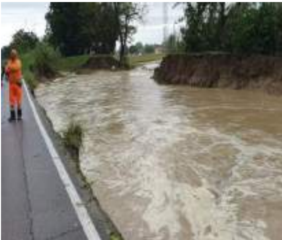
Torrente Rigossa: erosioni diffusa e rottura arginale in sponda destra conseguenti al transito dell'onda di piena
