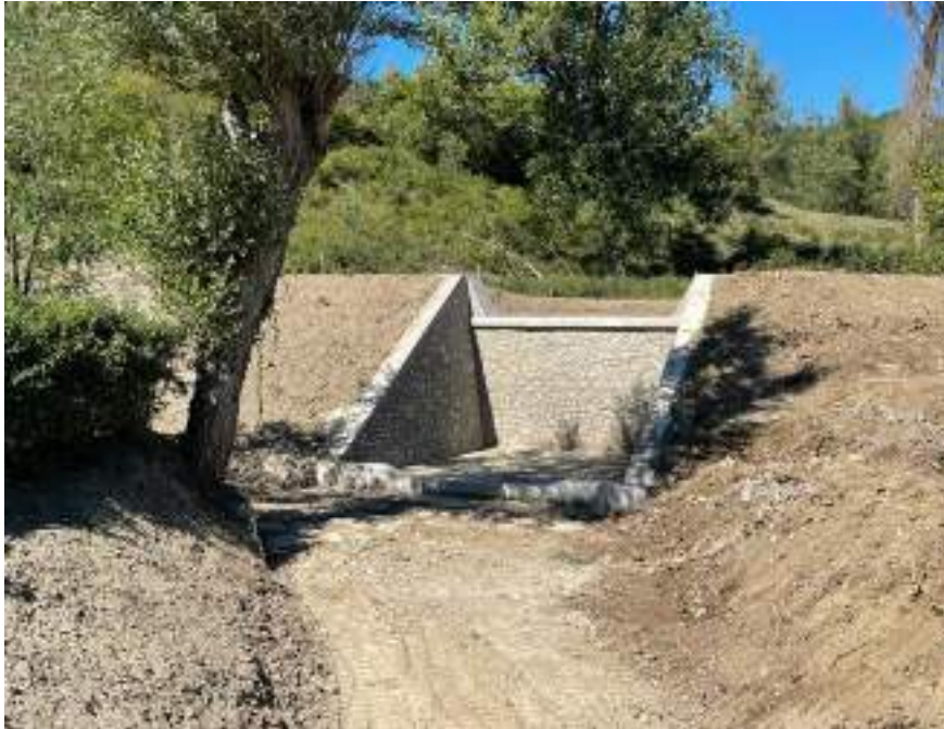
Lavori di ripristino di briglia in sassi parzialmente demolita nel fosso Barattoni in comune di Sogliano al Rubicone (FC)
